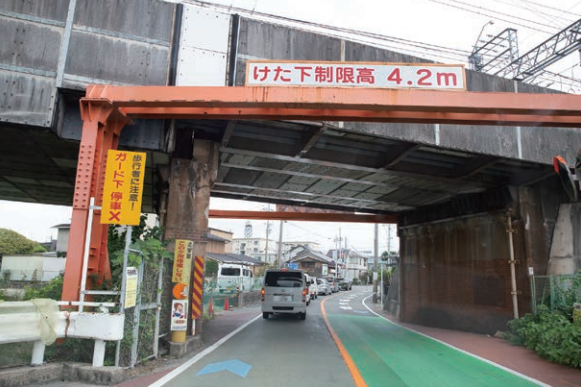
橋脚の外側に川を渡る歩行空間を設置する工事が年内着工の予定
