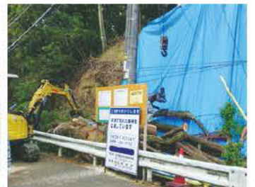
昨年の台風で土砂崩れした橋本東山本地内の補強改修工事。京都府の平成27年度災害に強い森づくり事業予算が活用され、危険木の除去と斜面の補強がされます。今年の夏には間に合いますが、工事開始までに要した時間が長く、皆さまにはご心配をおかけしました。今回の教訓を生かして、早期着工できるように働きかけます。今年の夏は大雨が降らない事を願います。
